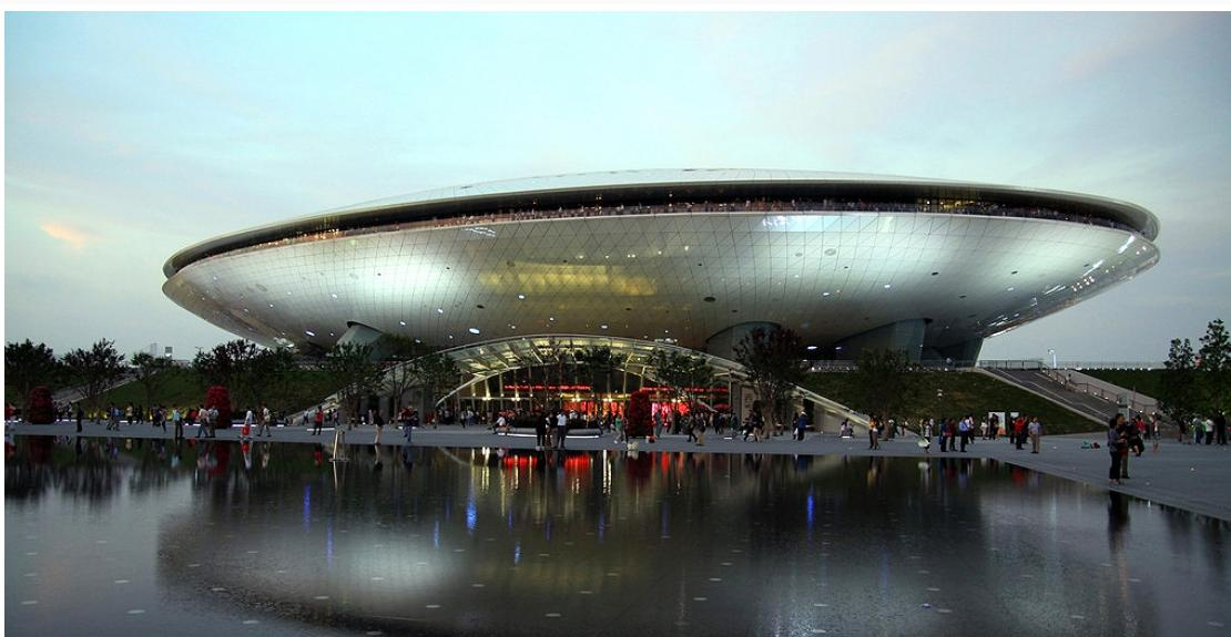
项目的设计按照3R原则，即减量化Reduce,再使用Reuse,再循环Recycle，考虑采用光电幕墙系统、江水源冷却系统、气动垃圾回收系统、空调凝结水与屋面雨水收集系统、程控型绿地节水灌溉系统，并通过多种有效的技术手段，对能源和水消耗，室内空气质量及可再生材料的使用等多方面进行控制，使演艺中心成为真正意义上的“绿色生态建筑”。空调系统采用江水源热泵、冰蓄冷与传统热水锅炉加空调做补充，使其即节能又安全可靠。使用了6台艾克森AC&AU系列换热器分别用于冰蓄冷系统、江水源热泵系统和空调热水系统。
